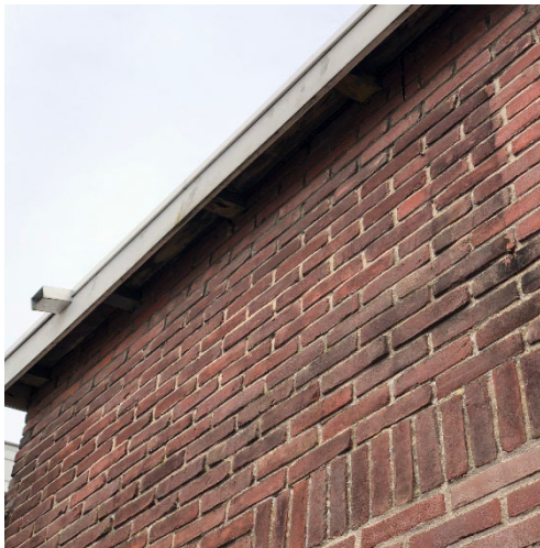
Figuur 10. Ruimte onder dakrand met dakgrind
