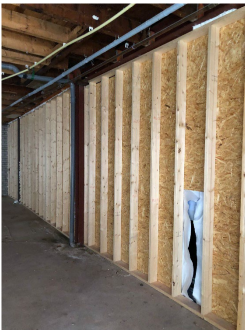
Figuur 12. Houten voorzet wand, wordt geïsoleerd
