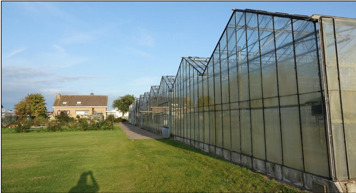
Figuur 8: Openstaattoevoeg in het opstal aan de Holenweg 8 gevuld met gaas.
