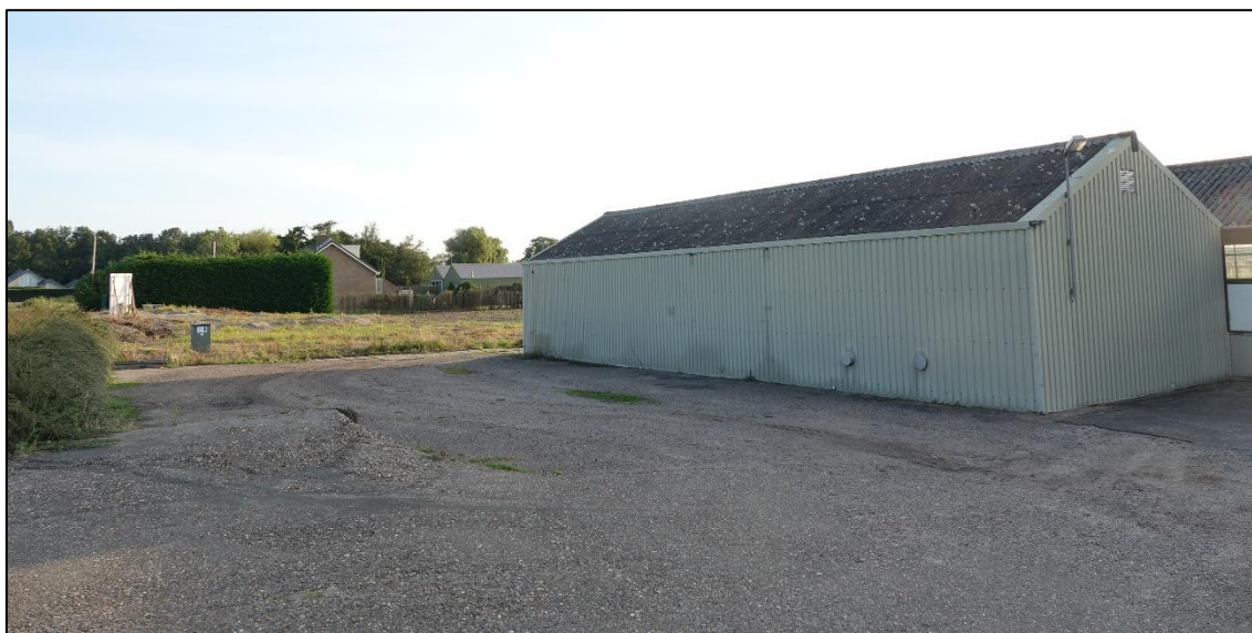
Figuur 7: De loods op het terrein van metalen platen en met een golfplaten dak.
