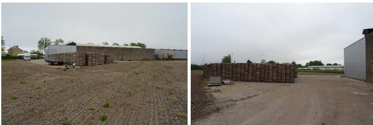
Afbeelding 3 t/m 6: de bestaande kavel met aangrenzende watergang en bedrijfsbebouwing Datum: 11-06-2021
