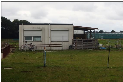
Te verwijderen tijdelijke bedrijfswoning.
