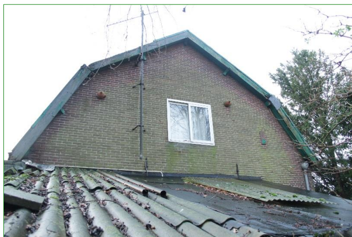
Kopse kant van het woonhuis.
