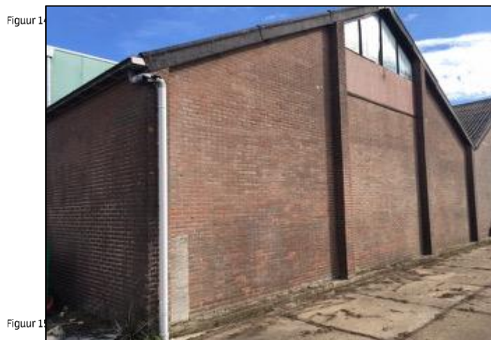
Foto 3 huidige situatie zijkant
