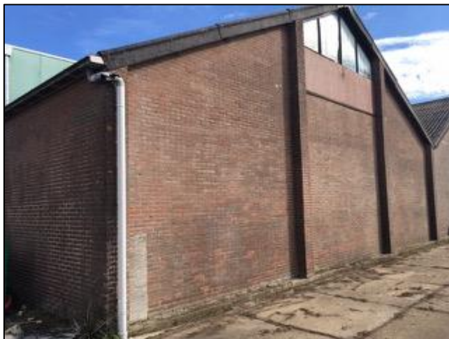
Figuur 15: Foto 3 huidige situatie zijkant
