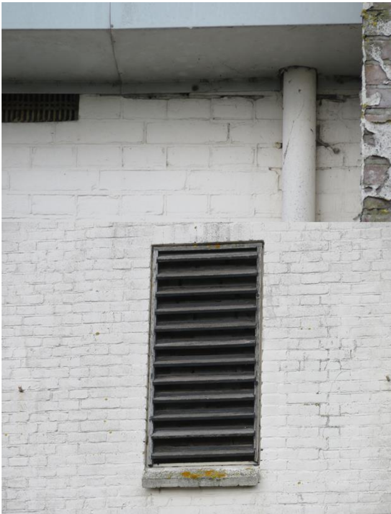
Met roosters afgedichte ventilatiegaten in kantoorgebouw/annex bollenschuur.
