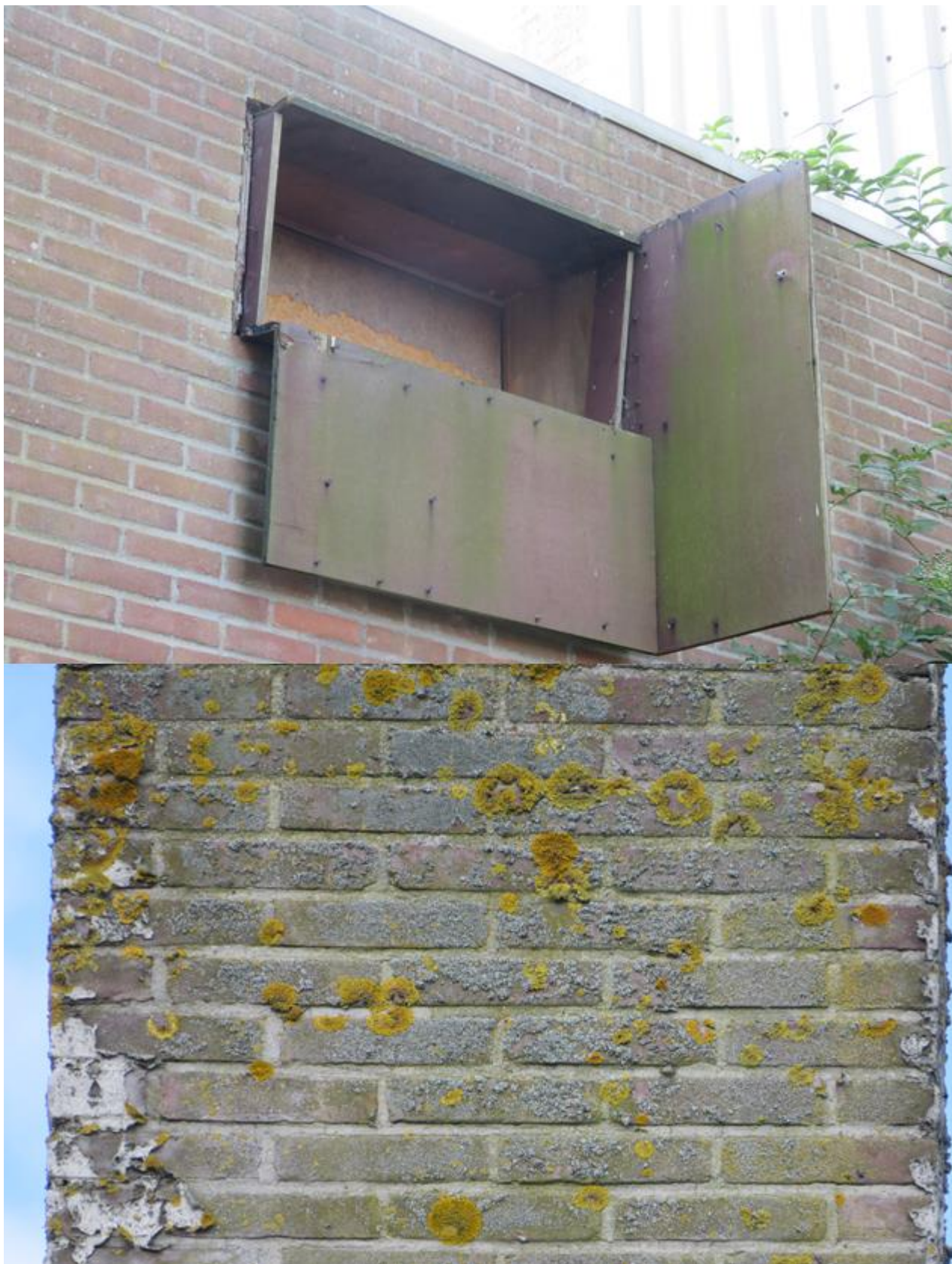
Geen ruimte in ventilatiegaten. Geen open stootvoegen in de schoorsteen.
