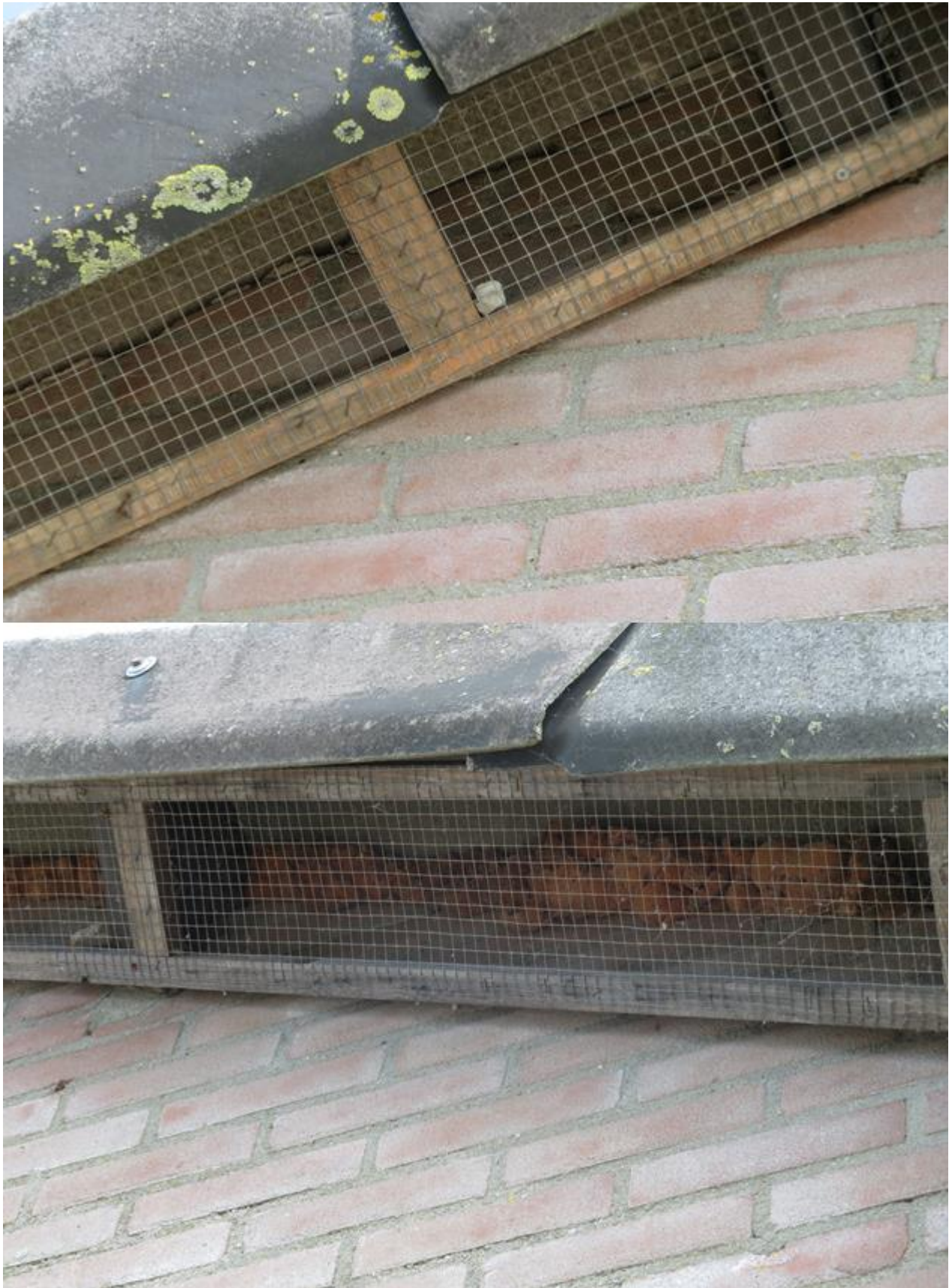
Met gaas afgedichte openingen tussen dak en voor(zuid)gevel.
