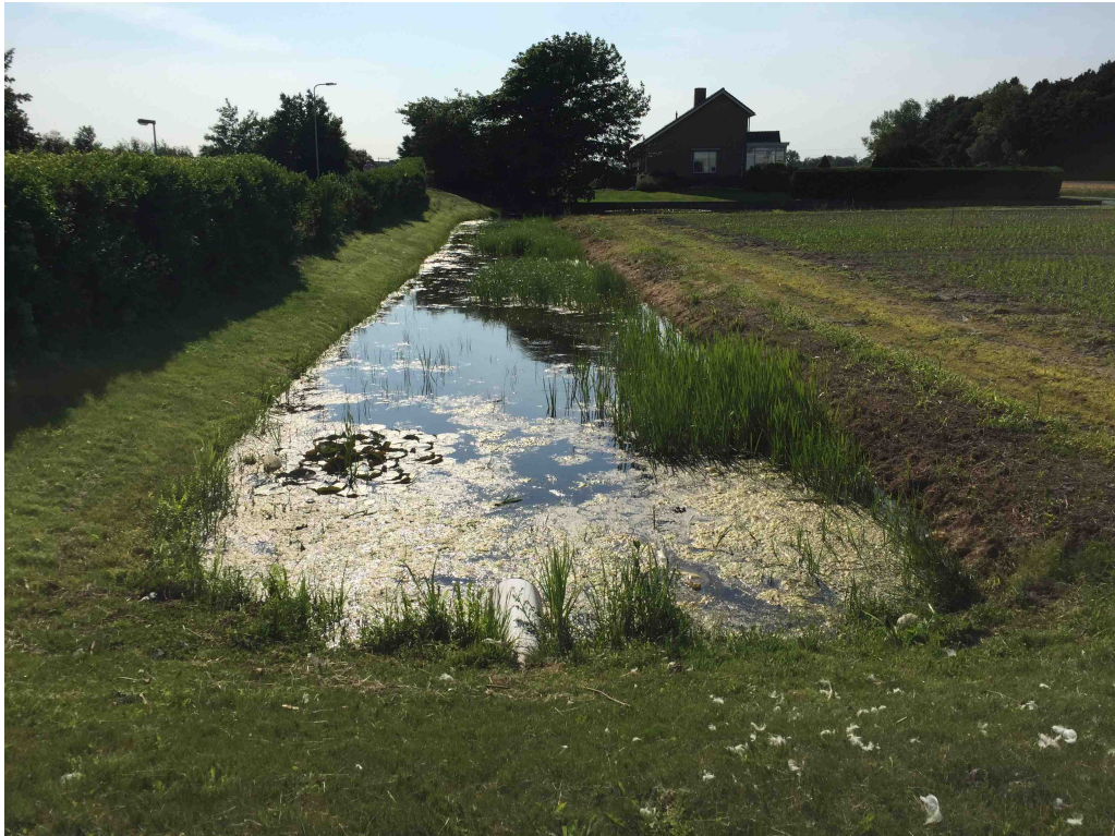
Figuur 3 De bestaande watergang(en) worden deels gedempt en vergraven. Per saldo wordt 500 m 2 oppervlaktewater toegevoegd ter compensatie van de aangebrachte verharding.
