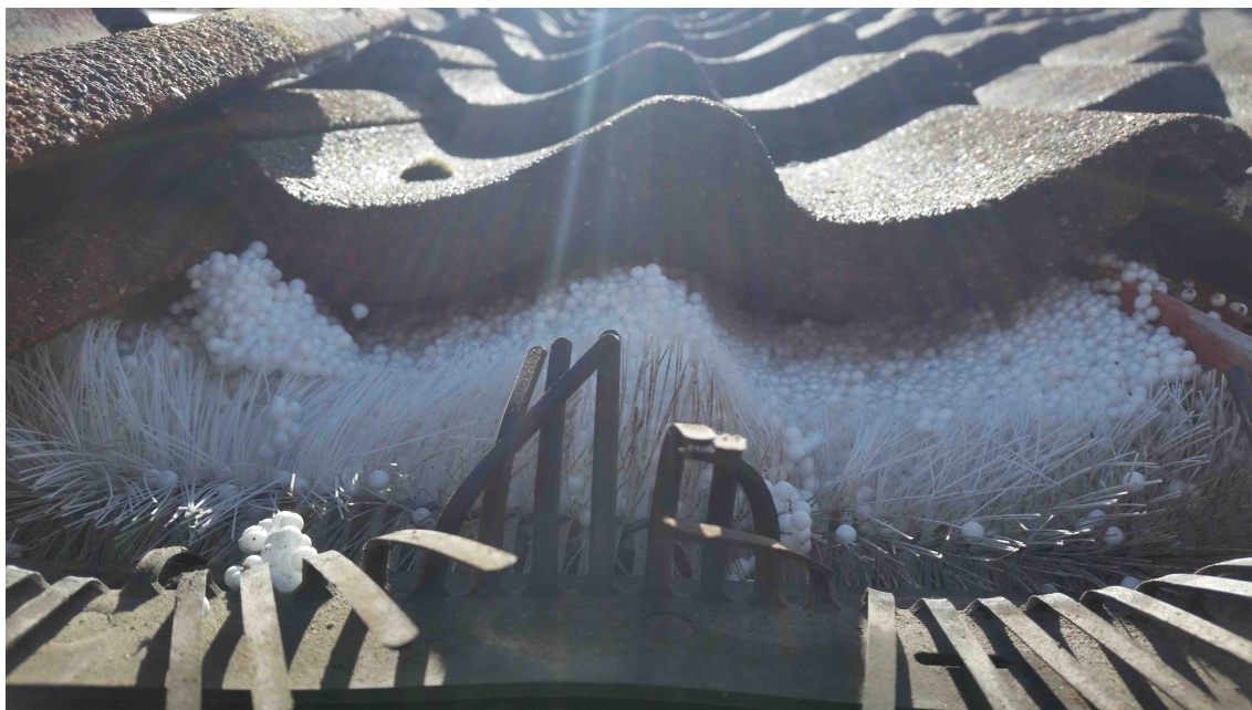
Afbeelding 2. De ruimte onder het pannendak is geheel gevuld met de isolatiekorrels.
