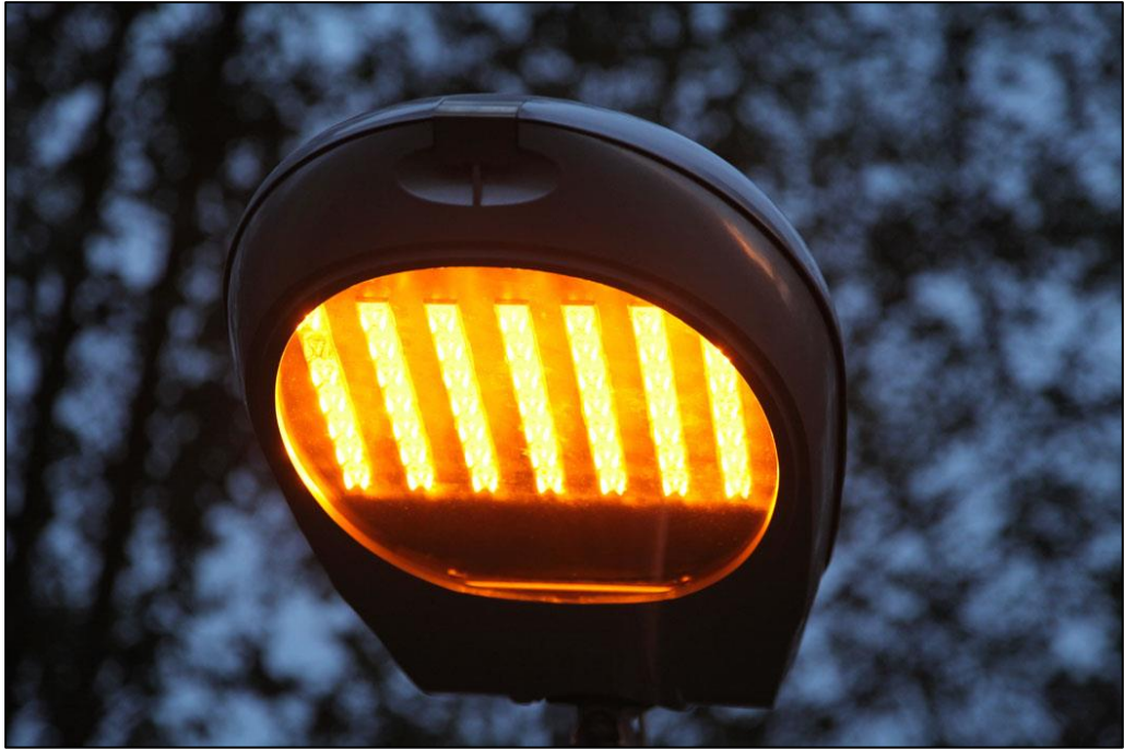
Speciale vleermuisverlichting. Amberkleurig licht is minder verstorend voor vleermuizen.
