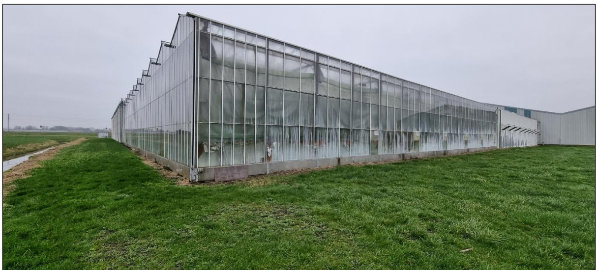
Afb 10: Beglazing overall intact, geen mogelijkheden om in- en uit te vliegen
