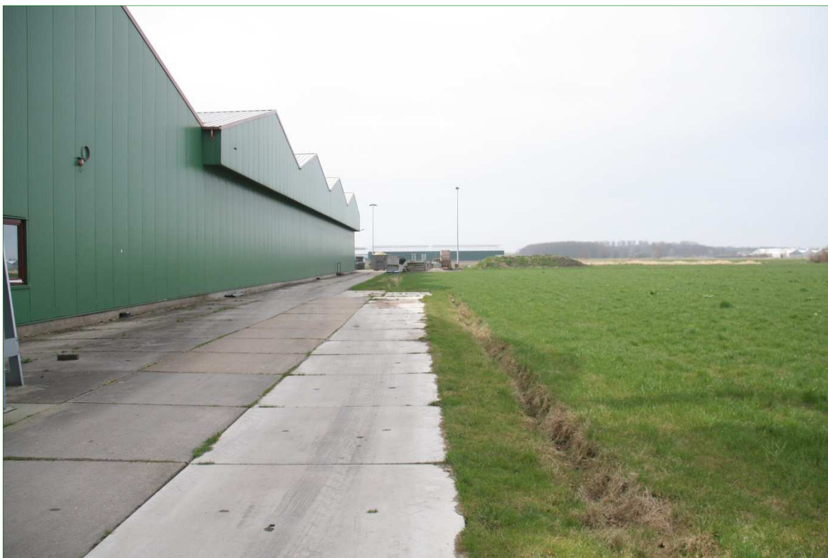
Impressie plangebied: uitbreidingszone langs de bestaande loods met verhardingen en een greppel.
