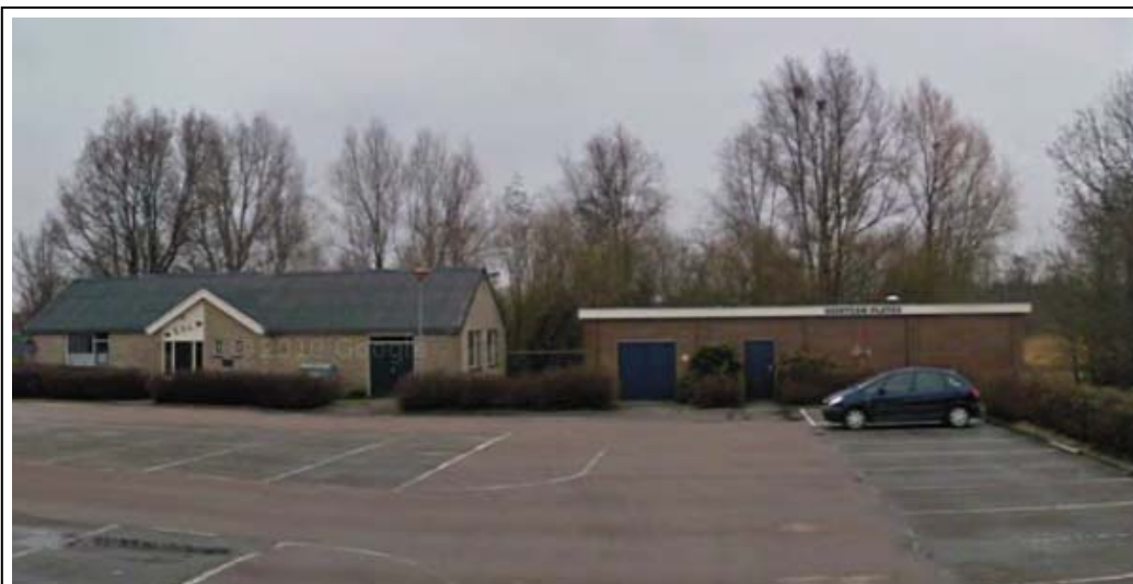
Figuur 2.1: foto vooraanzicht van het plangebied. rechts duivenvereniging ESL, links duikvereniging Platax en er tussen in de ontsluiting naar het plangebied
