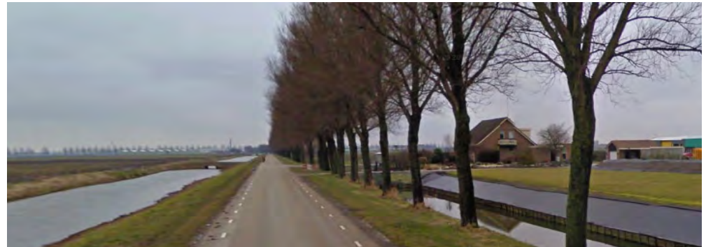
Slimweg, ter hoogte van het plangebied
