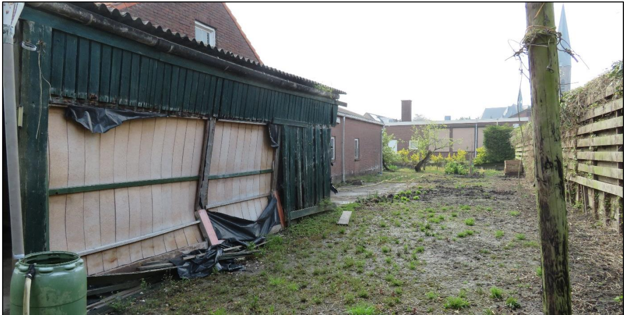
Afb 10: Deel met houten planken
