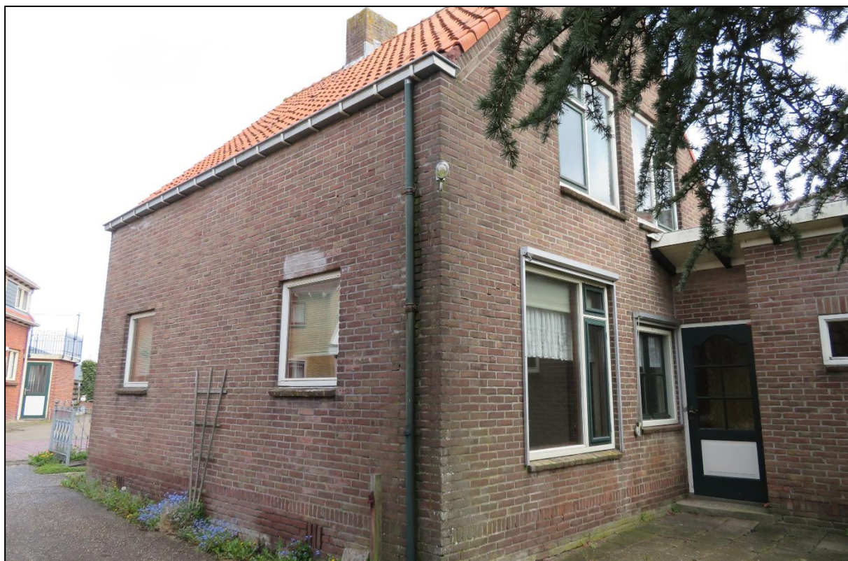
Afb 6: Achterzijde en zijgevel
