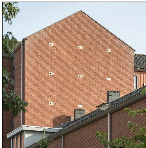
Afb 12 + 13: Gierzwaluwkasten ingemetseld (worden ook gebruikt door Huismussen)
