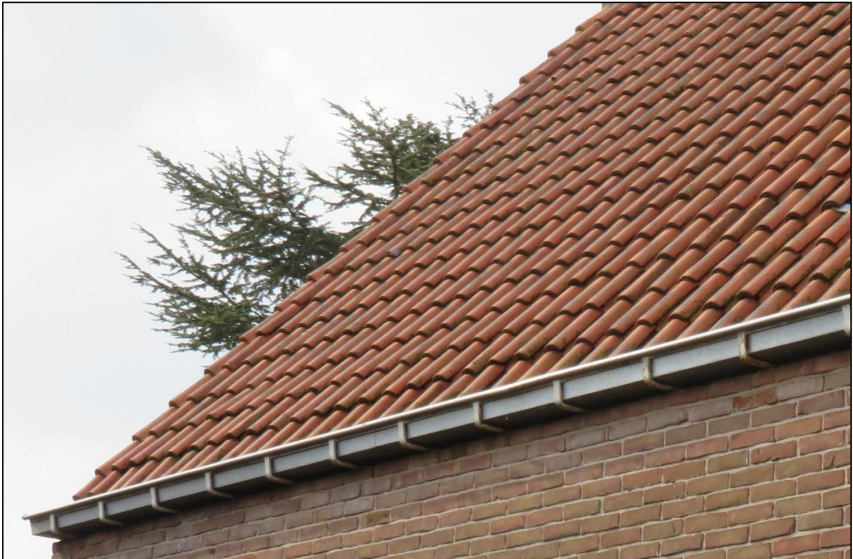
Afb 7: Vanuit de goot kunnen vogels onder de pannen komen. In het dakvlak ontbreken openingen
