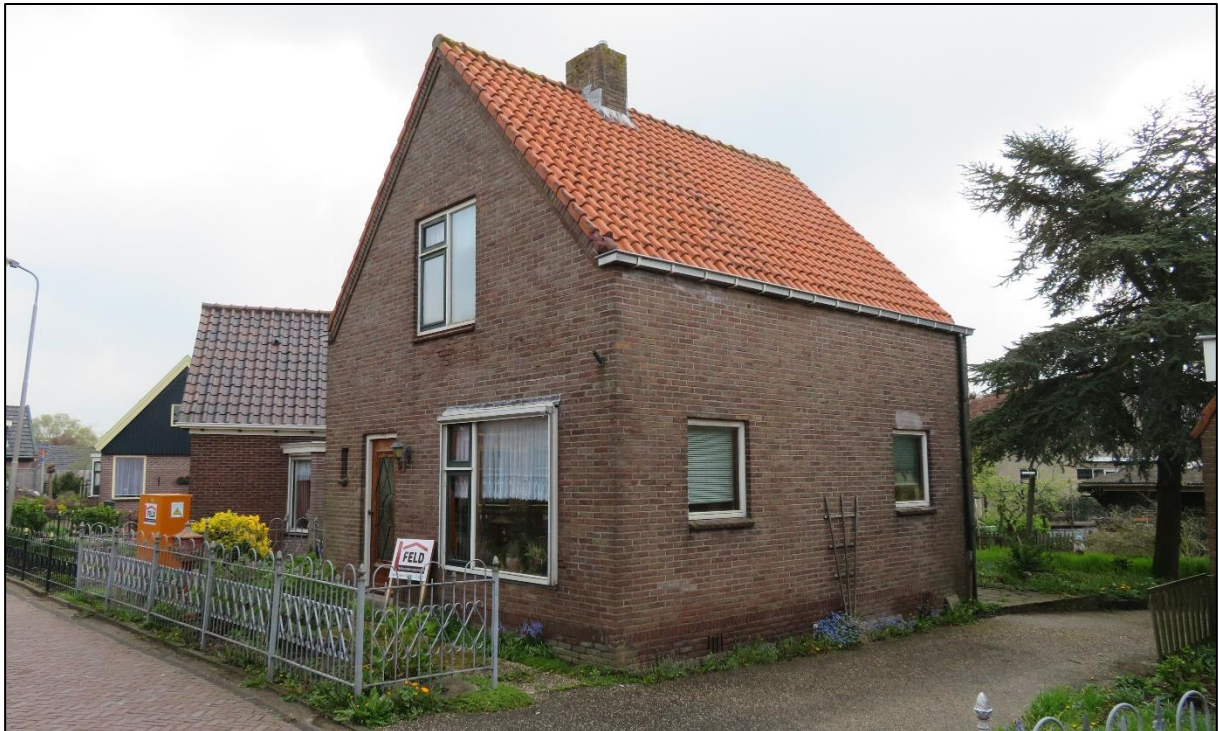
Afb 5: Voorgevel en zijgevel
