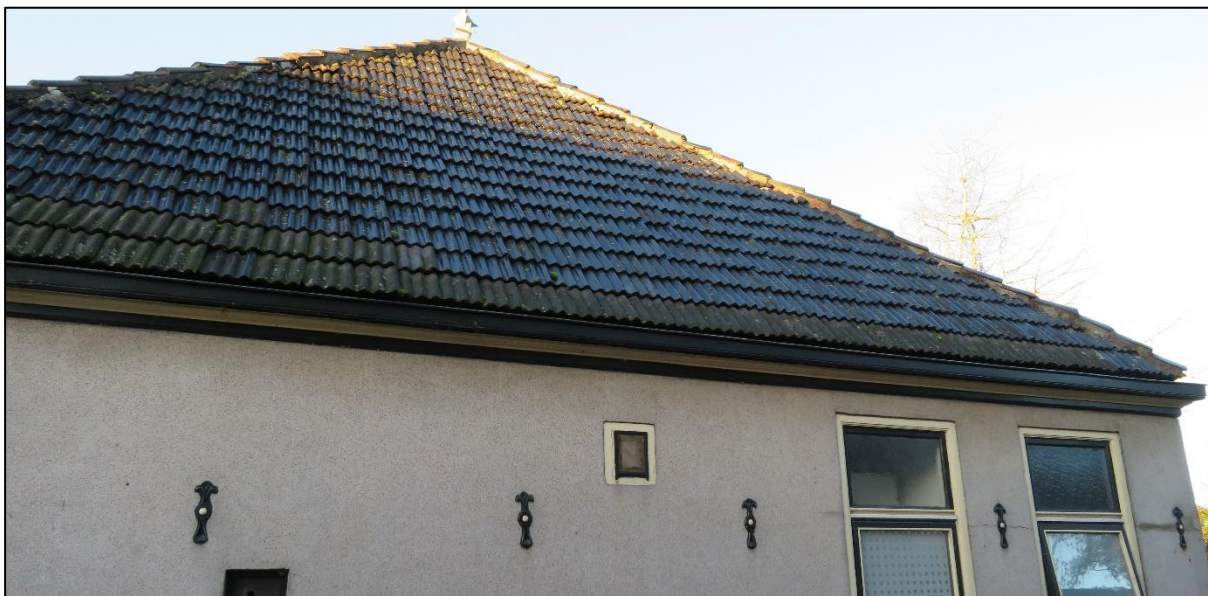
Afb 5: Zijgevel met pannendak (Friese Gegolfde pan)
