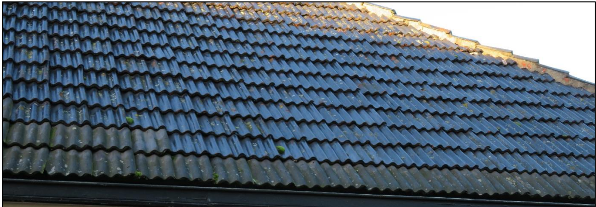
Afb 8: Dakpannen vertonen geen openingen welke gebruikt kunnen worden als in- en uitvliegopening.
