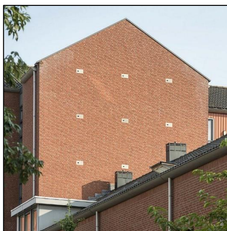
Afb 12 + 13: Mussenkasten ingemetseld (worden ook gebruikt door Gierzwaluwen)
