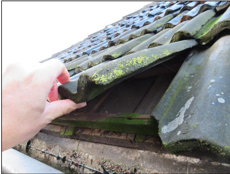
Afb 7: Schoon dakbeschot onder de dakpannen
