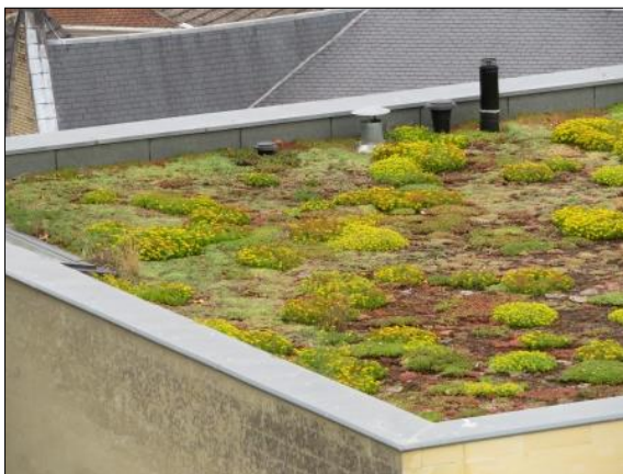
Sedumdak. Foto: BügelHajema Adviseurs.
