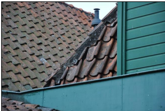
Afb 8: Geschikte openingen tussen de dakpannen
