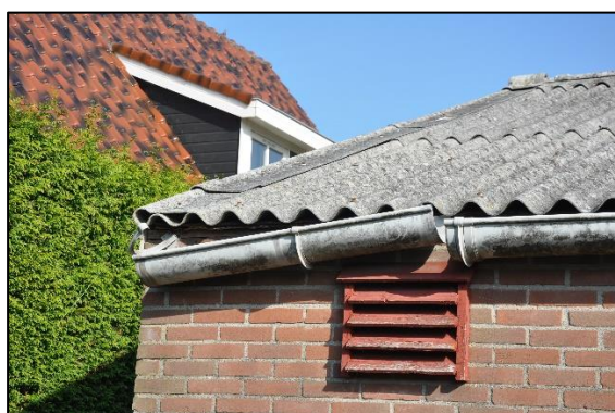
Afb 6: Openingen onder golfplaten
