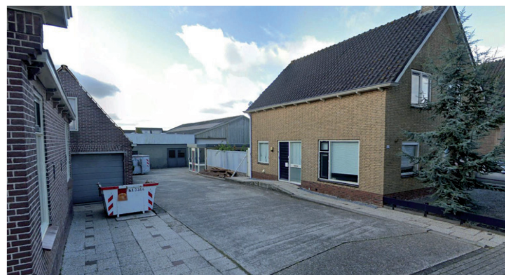
Foto's bestaande situatie
