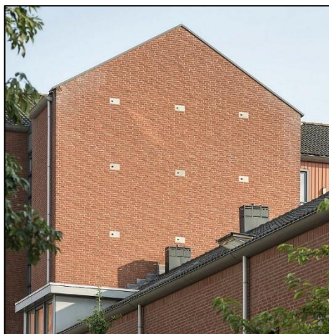
Afb 8 + 9: Gierzwaluwkasten ingemetseld (worden ook gebruikt door Huismussen)
