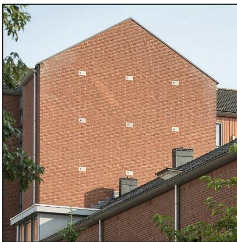
Afb 19 + 20: Gierzwaluwkasten ingemetseld (worden ook gebruikt door Huismussen)
