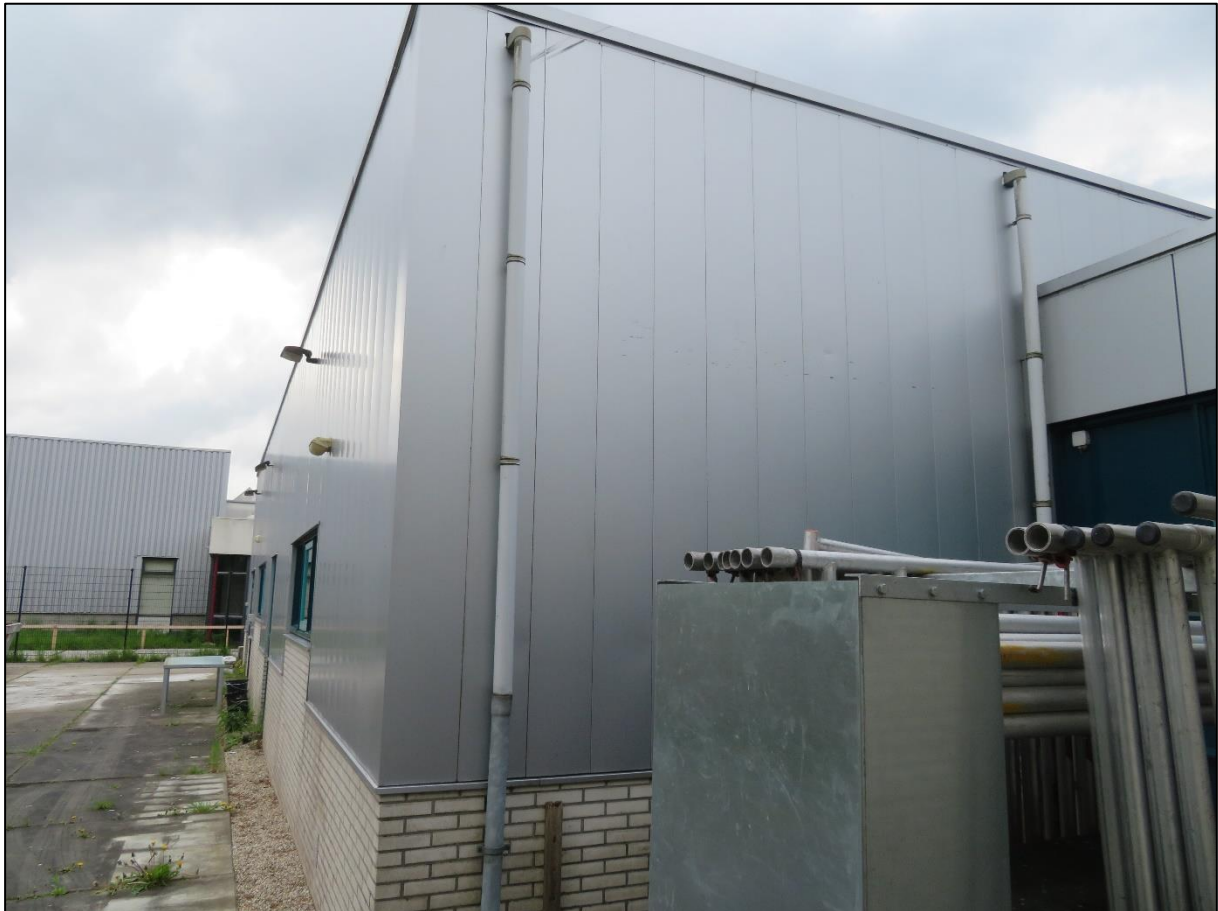
Afb 9: Ook hier geen openingen in gevels
