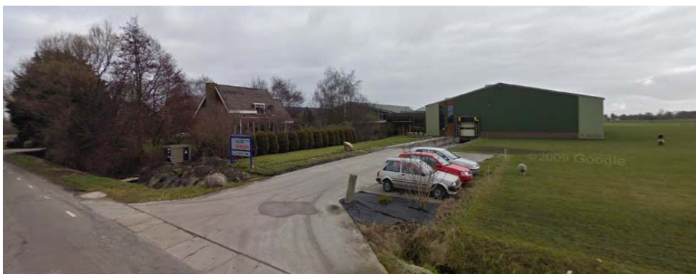
Figuur 9. Bestaande situatie, voorzijde met parkeren zou beter ingericht kunnen worden.
