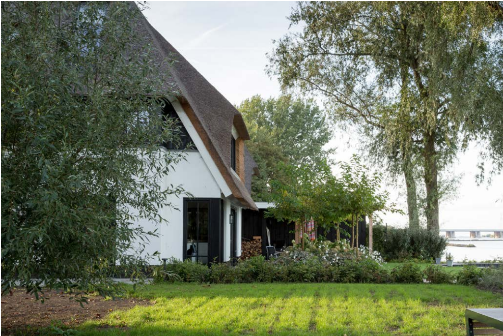
Woning met schilddak aan het water
