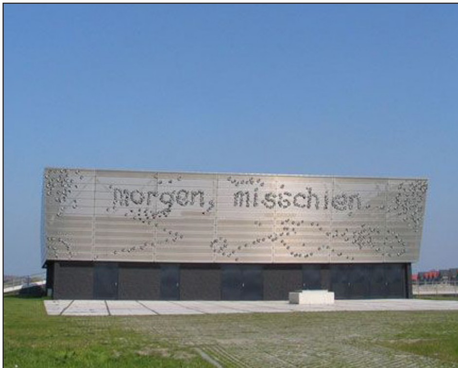
figuur 6: schachtgebouw Sophiaspoortunnel - Betuwelijn (bron: Rein Jelle Terpstra)
