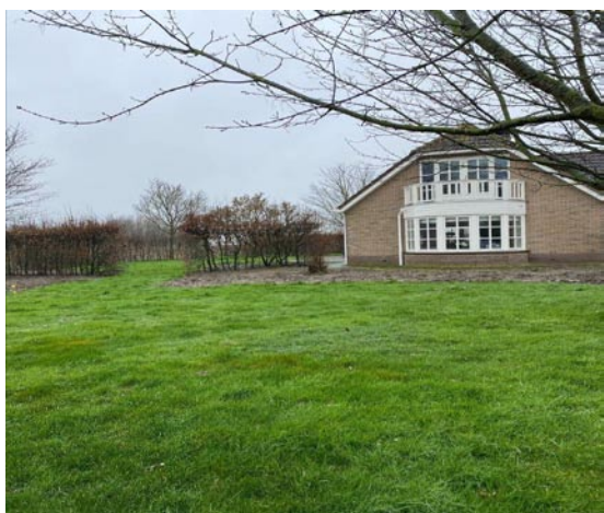
Foto 1: Vooraanzicht/Oostzijde van de onderzoekslocatie (woning).
