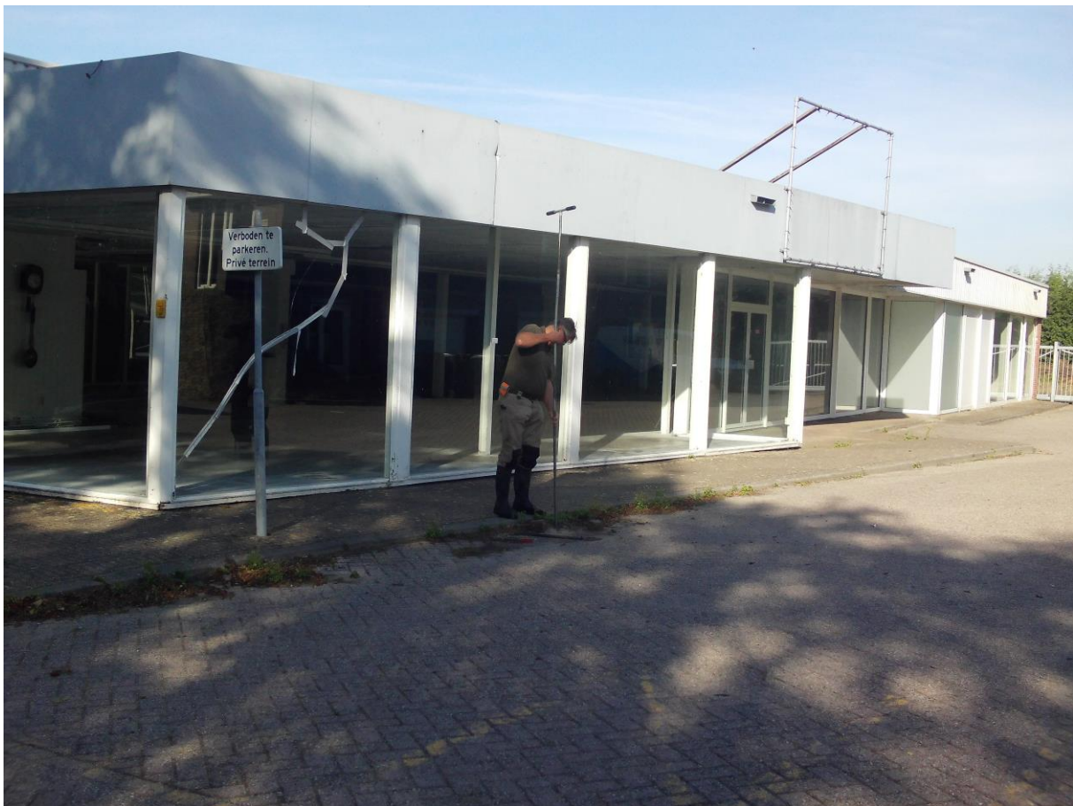
Figuur 9: Het plangebied gezien vanuit het noorden tijdens het zetten van boring 2
