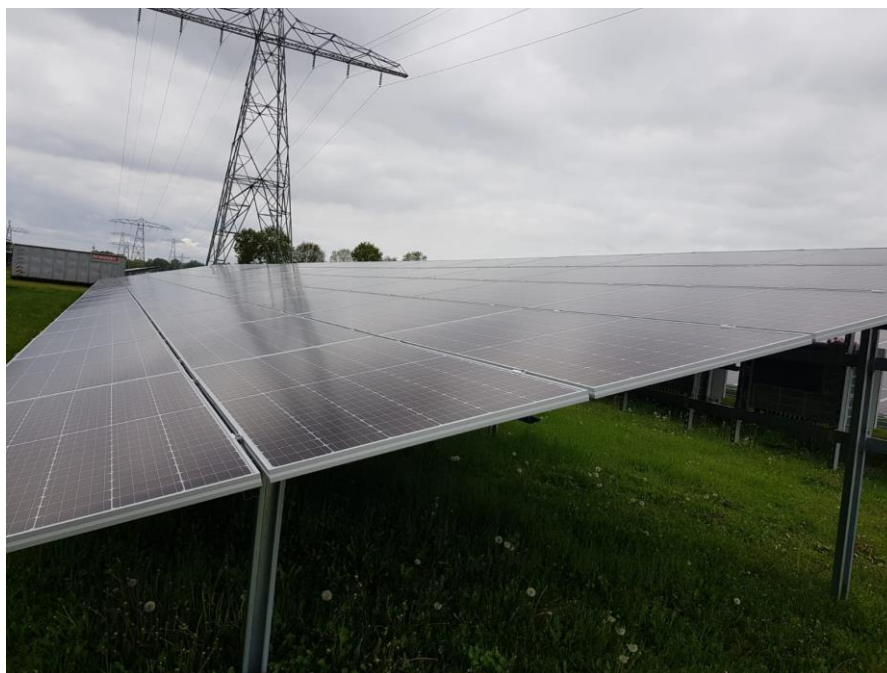
Figuur 33 Voorbeeld constructie met 1 centimeter open ruimte tussen panelen
