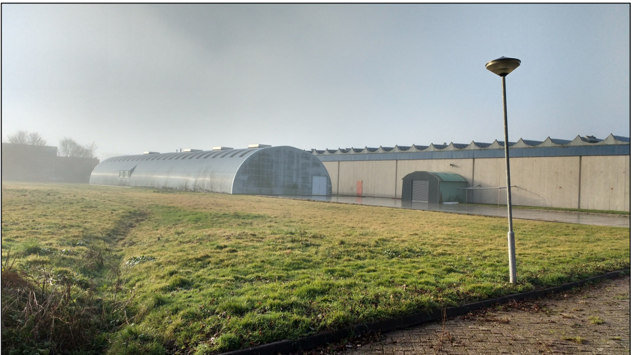
Terrein Helvoet, te slopen loodsen.
