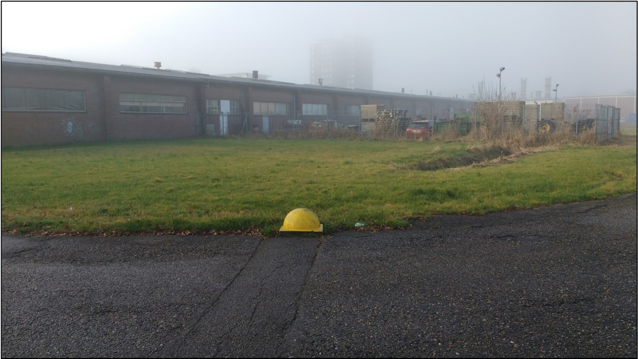
Terrein Vermaat, loodsen aan de zuidkant.
