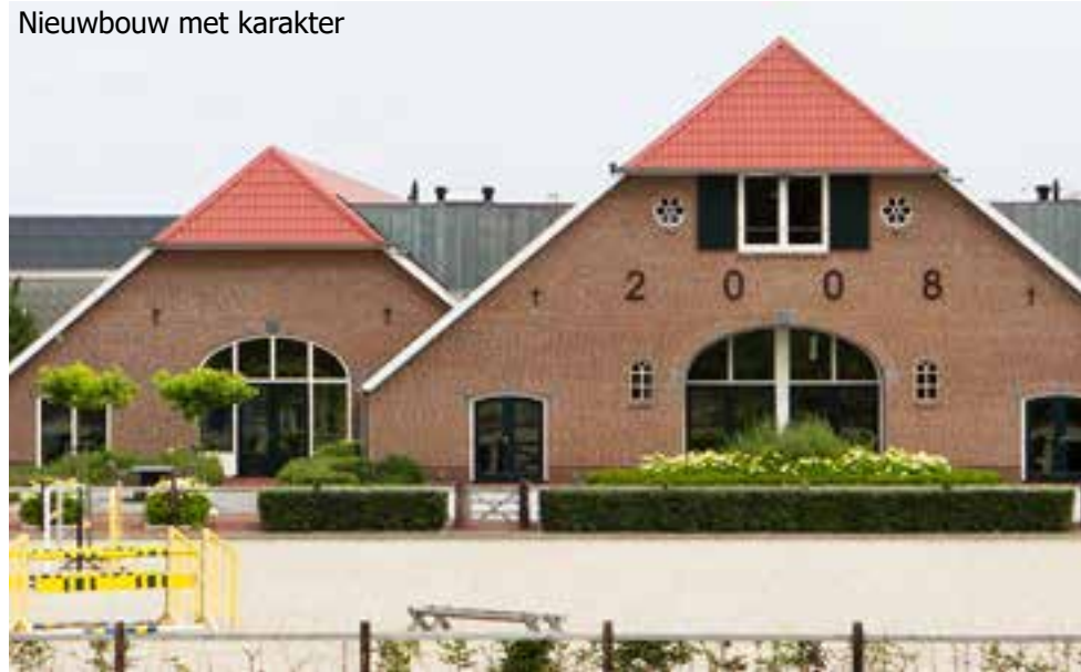
Aanbrengen gelaagdheid in gevels
