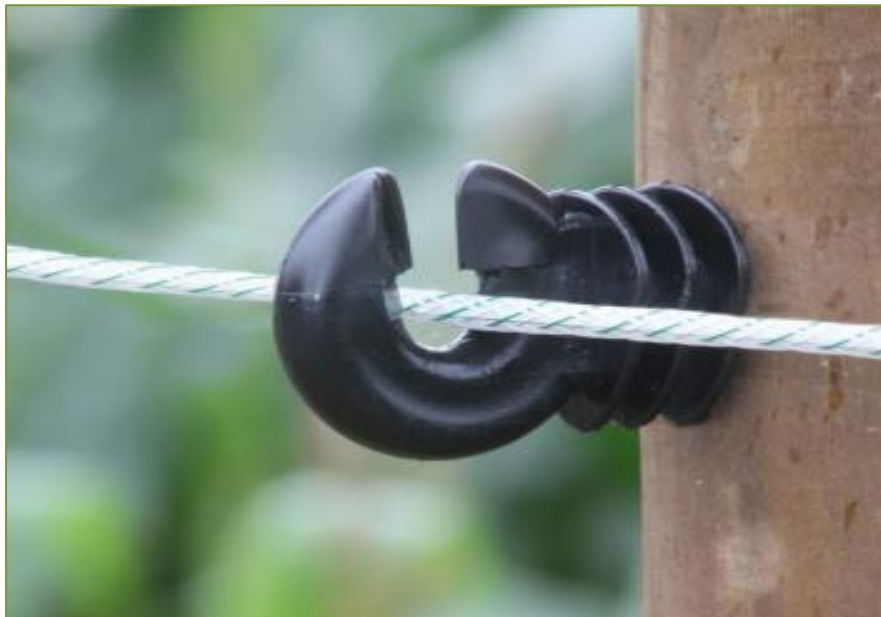
Foto 2: houten palen met isolatoren en schrikkoord zoals deze geplaatst gaan worden. Schrikkoord is veel minder opvallend dan schrikband.
