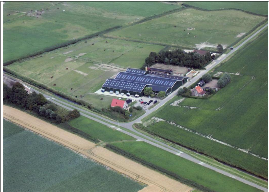
Afbeelding 2: Luchtfoto bestaande situatie.
