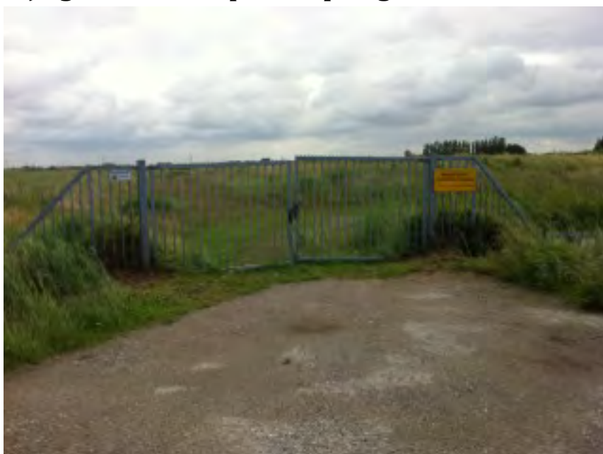
Toegang naar baggerdepot.
