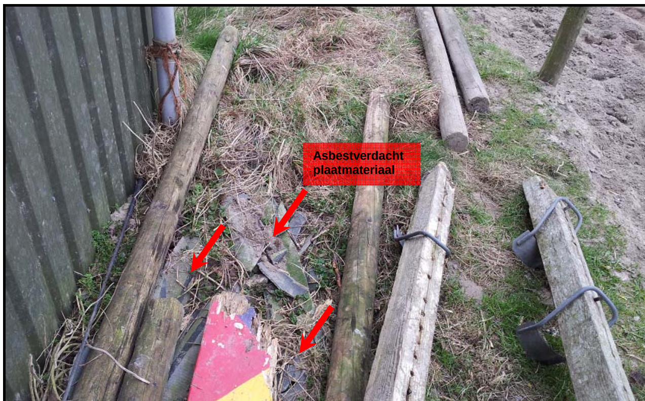
Foto1: asbestverdacht plaatmateriaal ter plaatse van deellocatie 1
