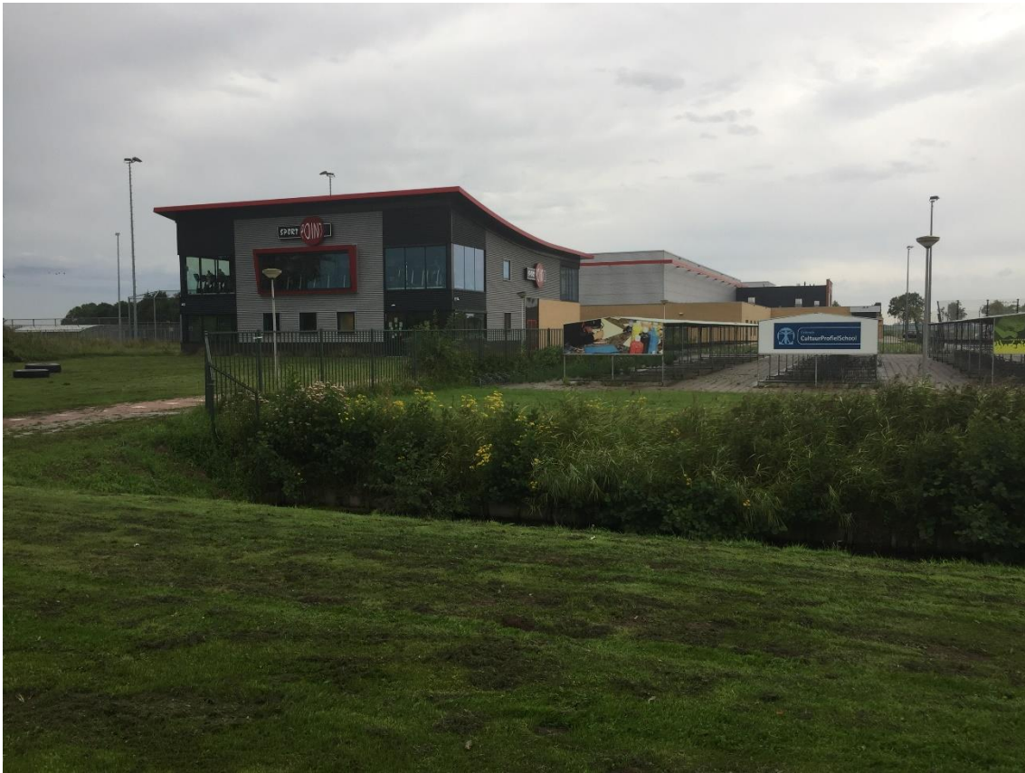
Figuur 2.4 Grootchalige sport- en schoolcomplexen ten noorden van de Provinciale weg
