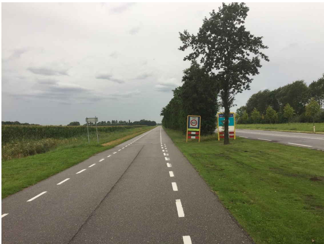
Figuur 2.3 Haringvlietweg met een dichte tussenbeplanting met de Provinciale weg
