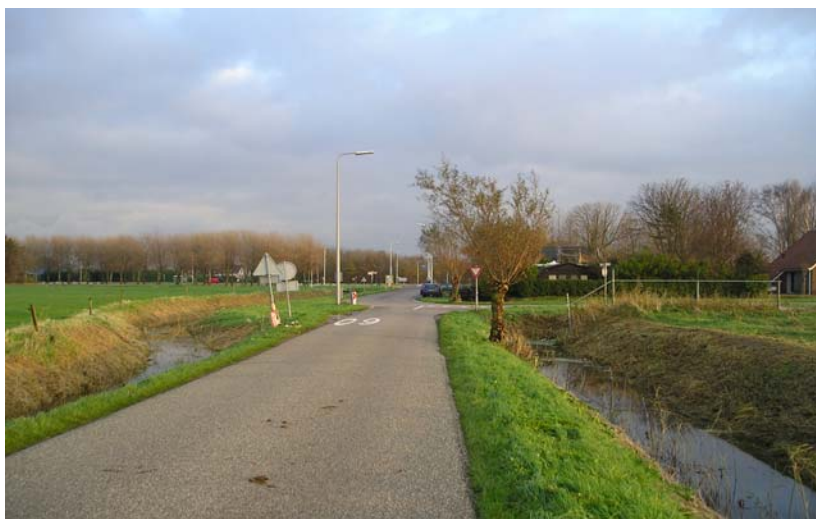
foto 9 vanaf Voorweg richting aansluiting AI-laan
