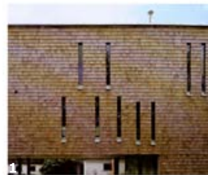
Horizontaal geled, geschubte huid (houten shingles)
