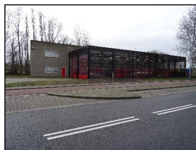
Figuur 8. Overzichtsfoto onderzoekslocatie: te slopen brandweerkazerne.
