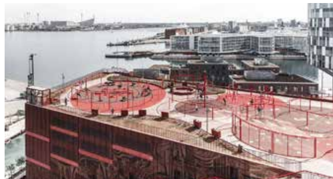
Openbare sportfaciliteit op een dak
