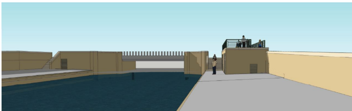
Impressie van het onderstation bij de Loosduinsekade vanaf het lage gedeelte van de kade, kijkend naar de brug van de Loosduinsekade.
