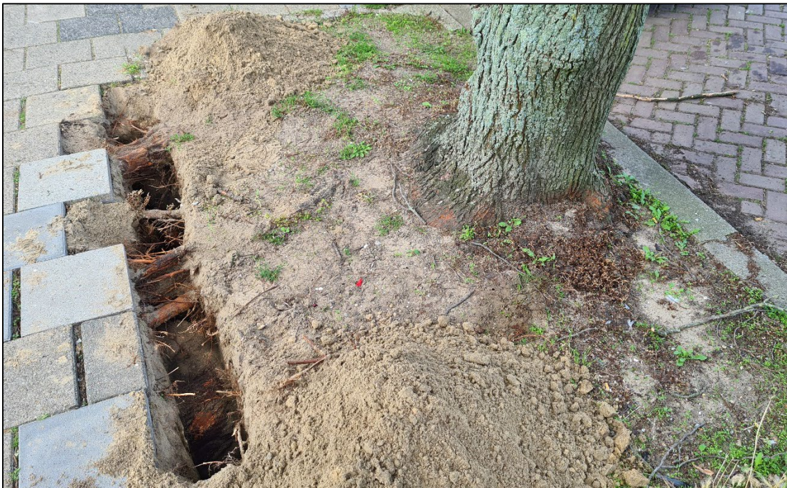
Afbeelding 19: Boom DH_356 heeft meerdere gestelwortels gevormd (tot 50 cm dik) onder het voetpad.
