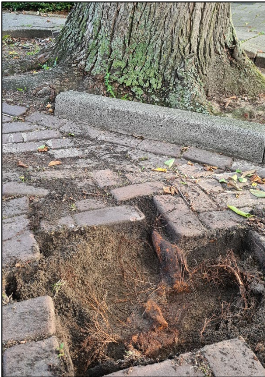
Afbeelding 17: Boom DH_45 heeft wortels gevormd onder de verharding van de parkeerstrook
