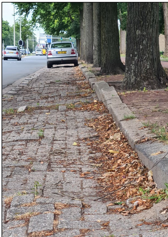
Afbeelding 6: Iepen in de Erasmusweg veroorzaken op grote schaal wortelopdruk.
