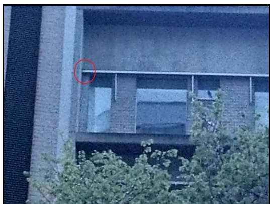
Afbeelding 2: Zomerverblijfplaats gewone dwergvleermuis noordgevel binnentuin in linker bovenhoek raamkozijn thv bovenste verdieping (met rode omlijning).
