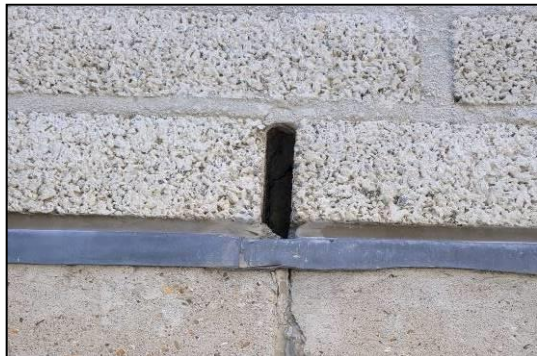
Afbeelding 2: Open stootvoeg
