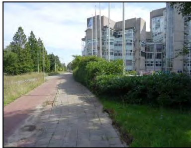
Figuur 4. Rand van het noordwesten van de onderzoekslocatie met haag en ten westen van de weg de groenstrook.
