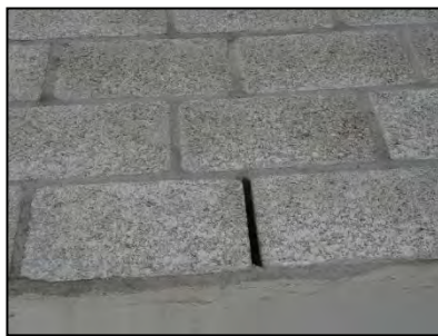
Figuur 11. Detailfoto open stootvoeg.
