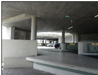
Figuur 6. Inpandige fietsenstalling noordoostzijde.
