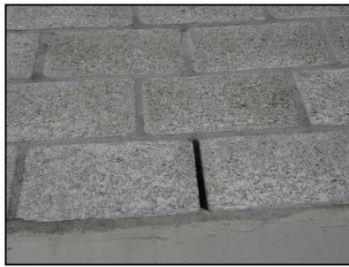
Figuur 11. Detailfoto open stootvoeg.
