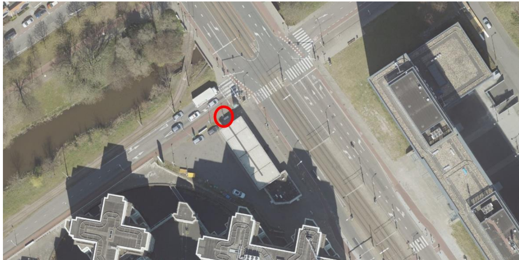
Figuur 2: Het tankstation, met brandstofpomp (rode cirkel) en de omliggende gebouwen.
