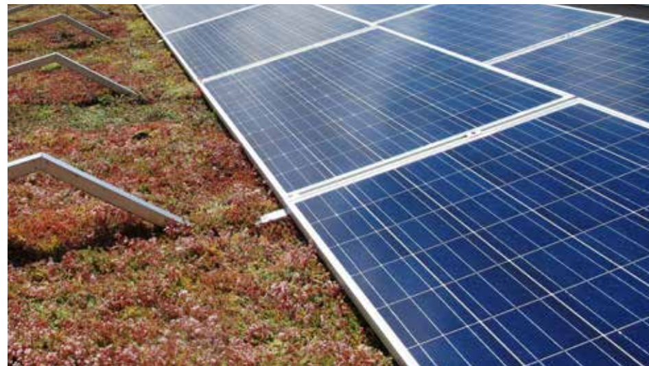
Groen energiedak kan een bijdrage leveren aan de waterbergende functie van het dak
